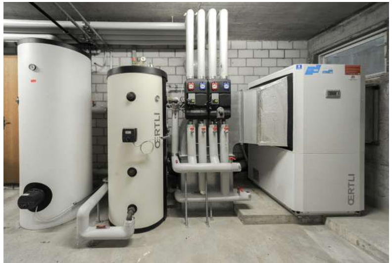
Technikraum Luft- / Wasser Wärmepumpe wurde im 2016 neu eingesetzt und ist noch voll funktionsfähig
